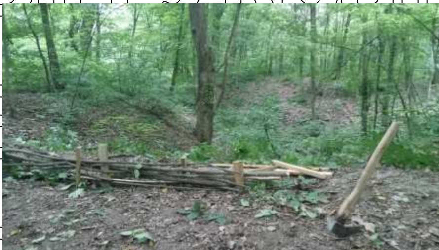
Рис. 4.7. Влаштування плетених загат у відвершку яру для кольматажу
