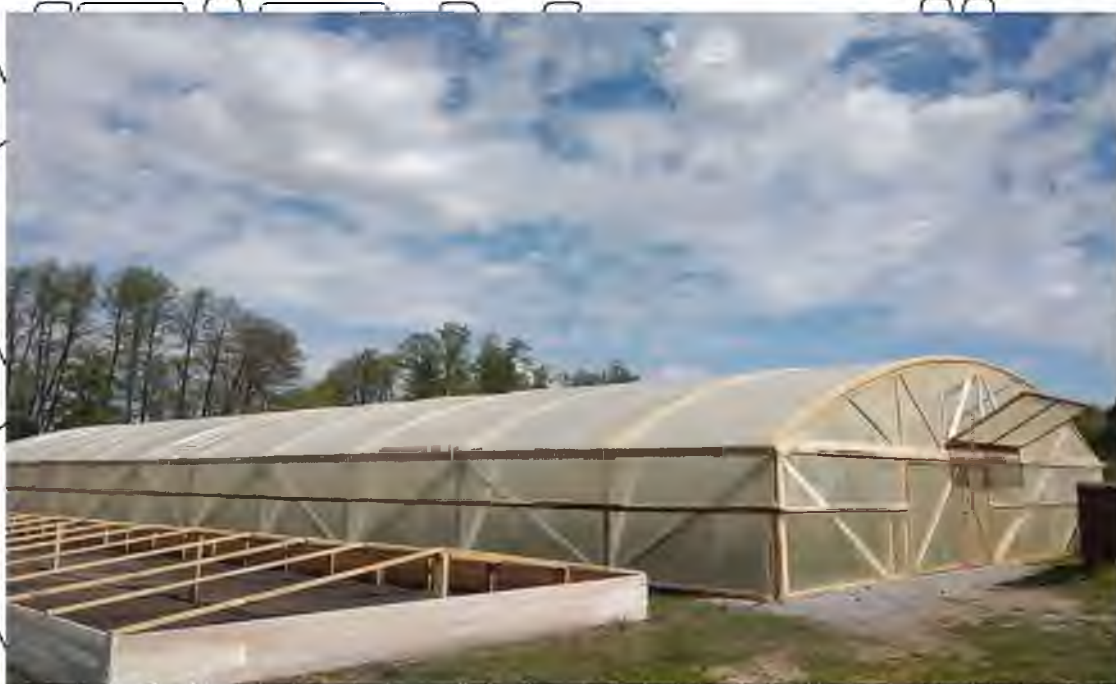
Рис 4.1. Загальний вигляд теплиці
