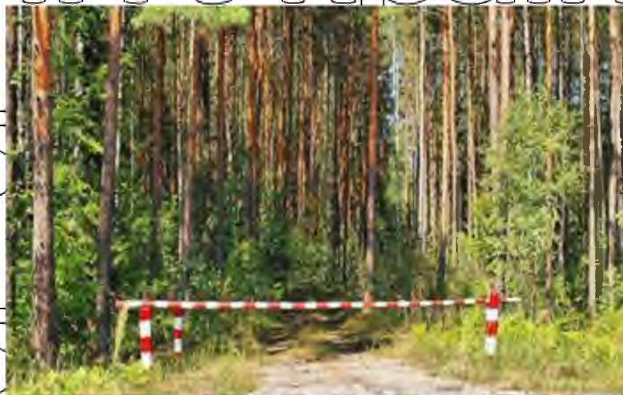
Рис. 4.10. Шлагбаум на лісовій дорозі
