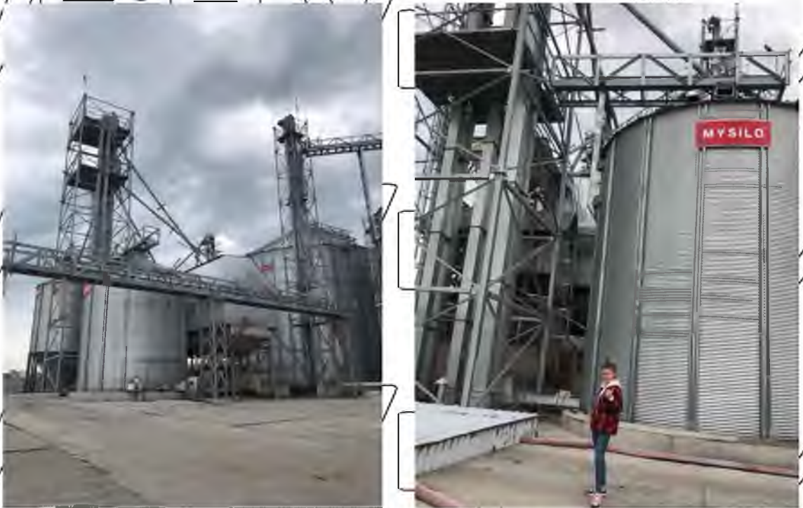
Рис.1.2. Зерносушарка Mysilo MX-40
