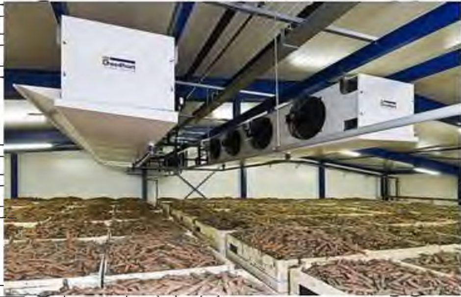
Рис. 1.3. Зберігання коренеплодів моркви у контейнерах в умовах стаціонарного сховища-холодильника з вентиляванням
