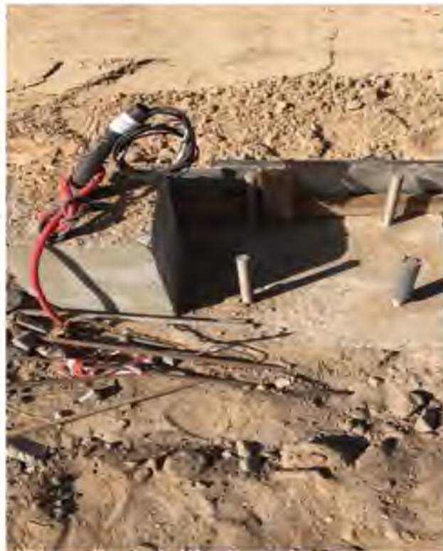
Рис. 2.3. Анкери для монтажу Г-подібного світильника
