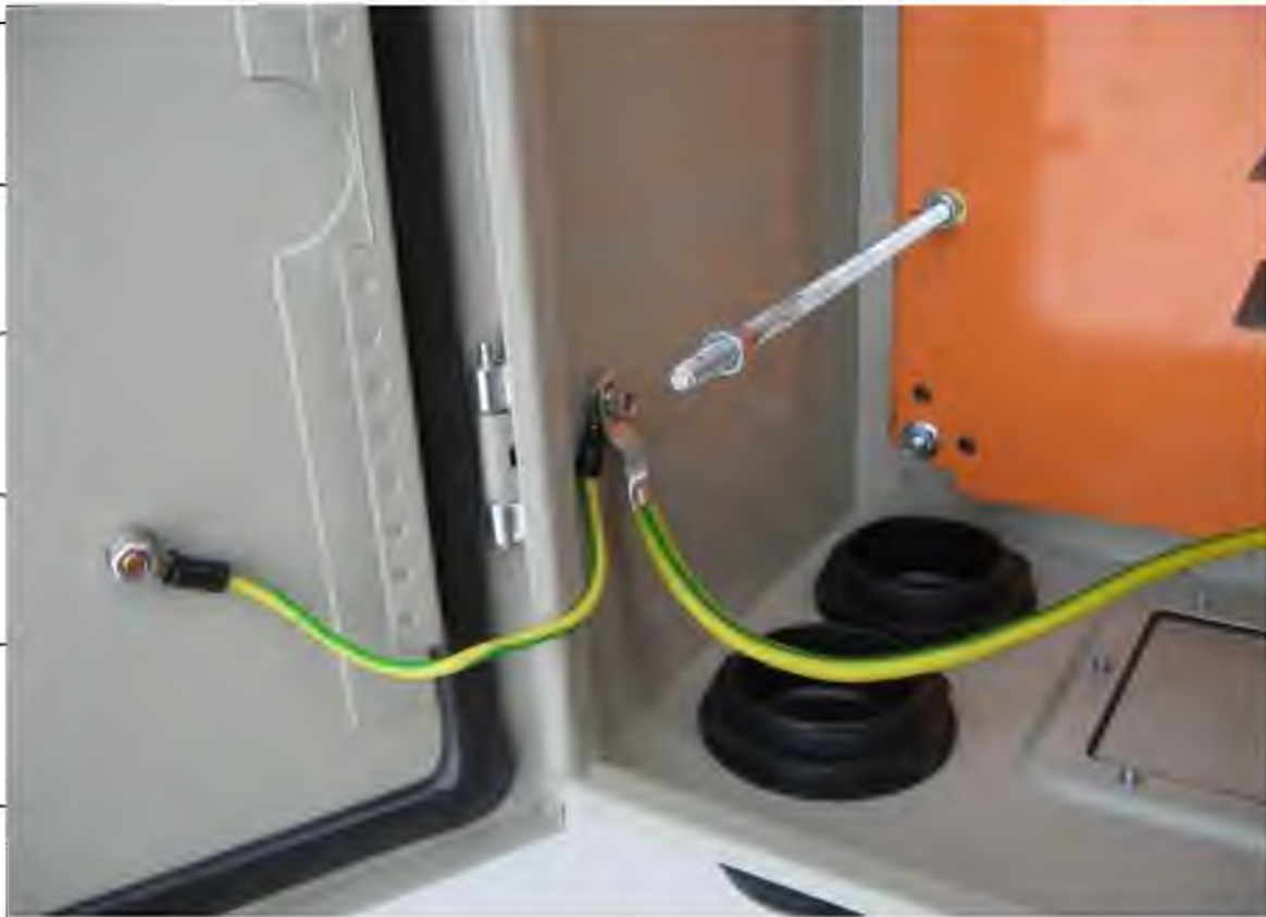
Рис. 6.2 Заземлення щитів
